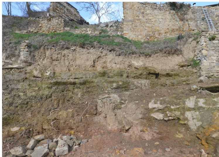
Fig. 1 : vue du site après les terrassements réalisés par D. Moliard, en mars 2016.
